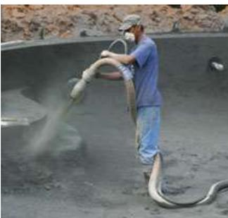
El cuarto paso consiste en la proyección del hormigón a alta presión en toda la superficie de la piscina.
